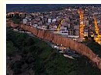
La frana di Niscemi.
