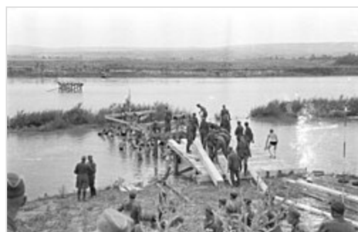
Niemieccy inżynierowie budują most pontonowy przez Pрут (1 lipca 1941 roku)
