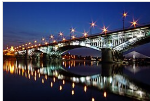
Na znajdującym się w granicach miasta 28-kilometrowym odcinku Wisły znajduje się 11 stałych mostów, dziewięć drogowych i dwa kolejowe. Most Poniatowskiego , w oddali most Świętokrzyski
