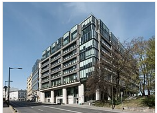
Centrum Giełdowe, siedziba Giełdy Papierów Wartościowych, Krajowego Depozytu Papierów Wartościowych i Towarowej Giełda Energii
