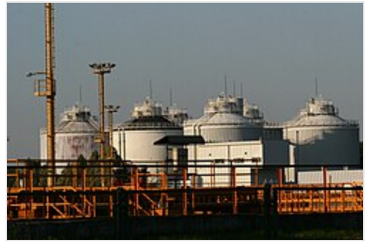
Oczyszczalnia Ścieków „Czajka”, największa oczyszczalnia ścieków w Polsce
