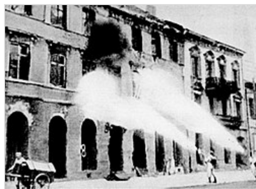
Niemieckie Brandkommando podpalające warszawską kamienicę
