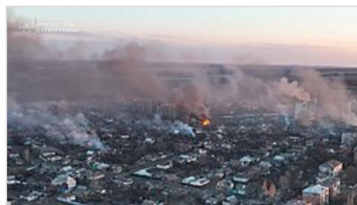
Zniszczony w trakcie wojny Bachmut
