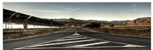
Plataforma Solar de Almería
